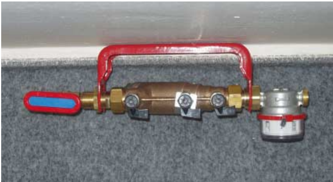
Fillset oddělovací člen s vodoměrem
